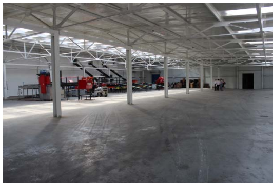
construcția/reconstrucția halelor de producere
